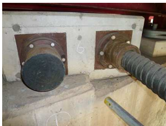
写真-6 定着部コンクリート
