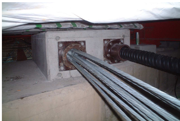
写真-4 PC鋼材の挿入
