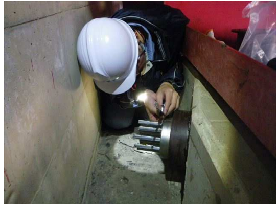
写真-12 ウェッジ出し測定状況
