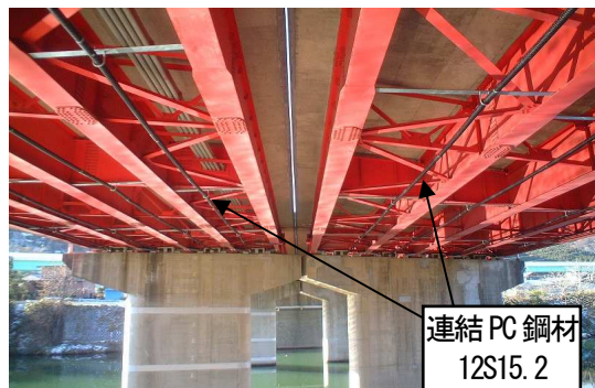
写真-1 連結PC鋼材配置
