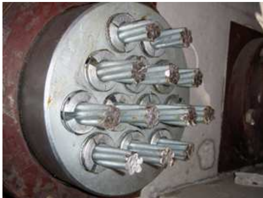
写真-10 PC鋼材および定着具の現況
